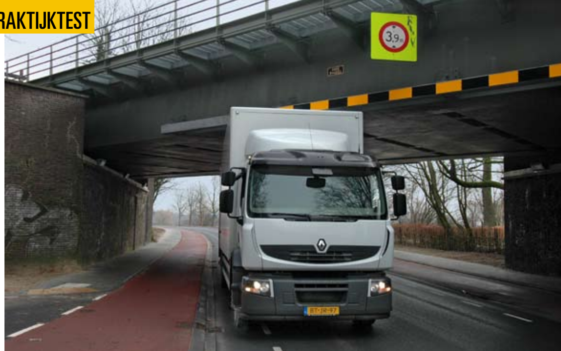
De TomTom stuurt ons onder dit viaduct bij Rheden door: het gaat, maar is erg krap.
